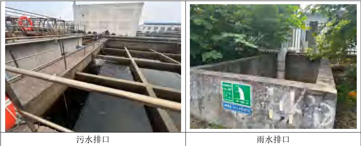
图 4.1-1 雨污水排口照片
